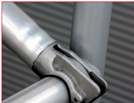
Gepresste Verbindung zwischen Klaue und Strebenrohr
