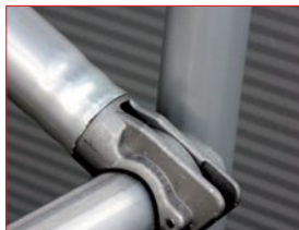
Čvrsta veza između spojnice i cijevi
