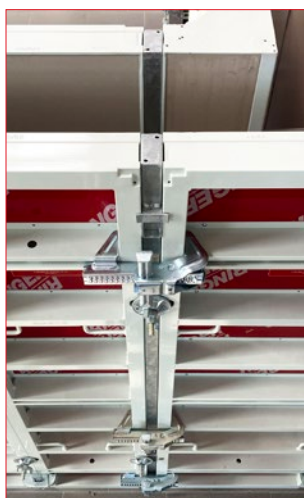
Master element za izjednačavanje 2 / 3 / 5 / 10 cm
