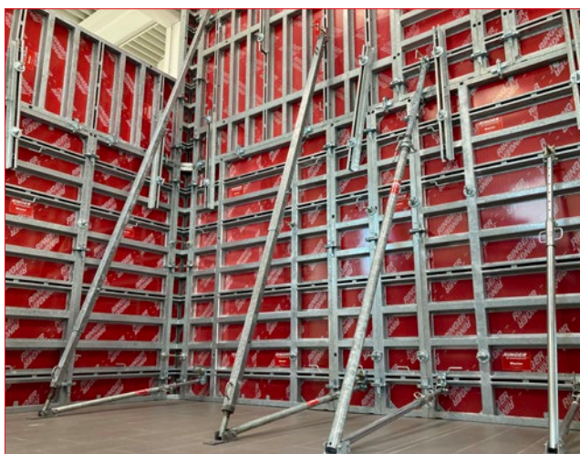
Kosnik veličine 1 / 2 / „G“ produžetkom do visine oplate 10 m
