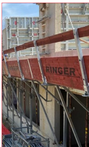
3S platforma za betoniranje
