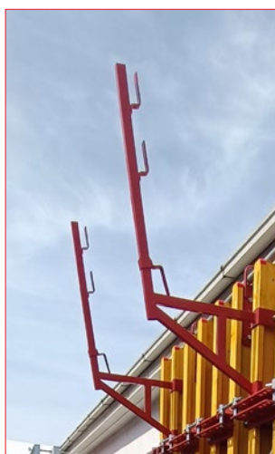
H20 konzola za betoniranje
