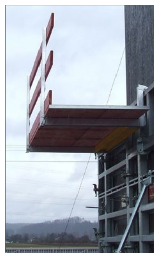
Platforma za betoniranje „L“ za Sistem 2000
