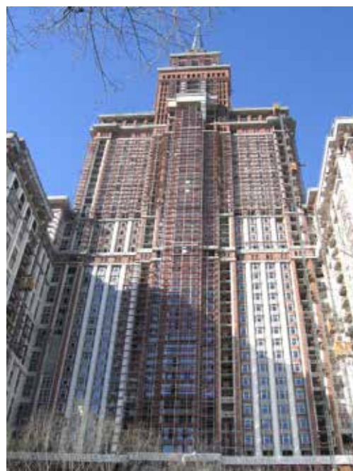
Skela s dvostrukom ogradom, visoka 120 m, Moskva
