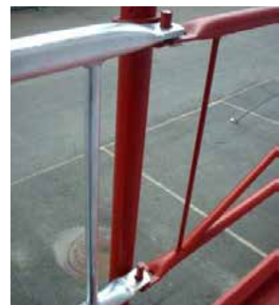
Aluminijska i čelična skela mogu se kombinirati
