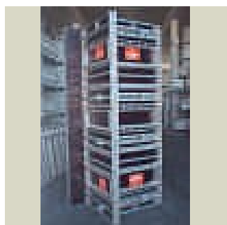
UNI elementi za betoniranje stupova
