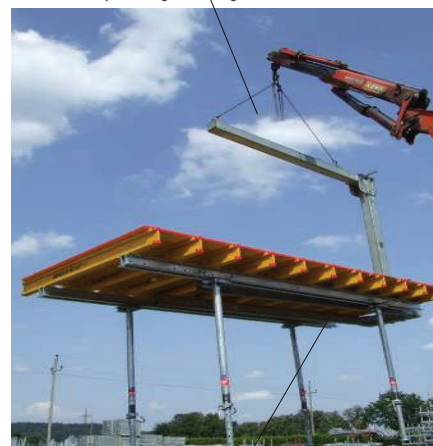
Vilice za premještanje stola za betoniranje
