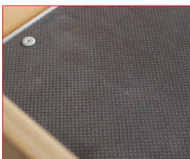
Plattform mit rutschsicherem Sperrholzbelag
