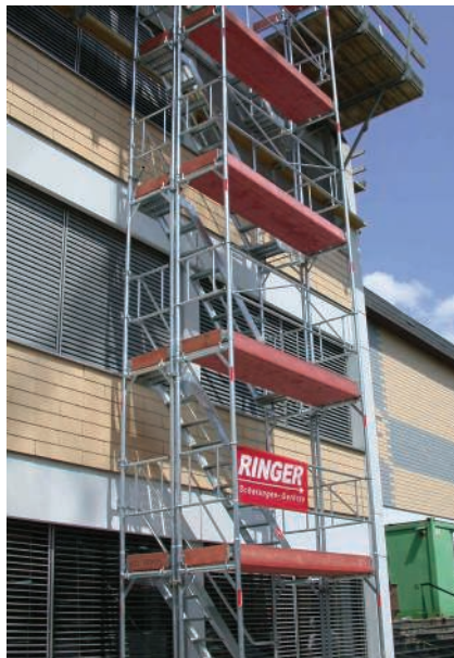
Schodišťové věže s ALU žebříkem
