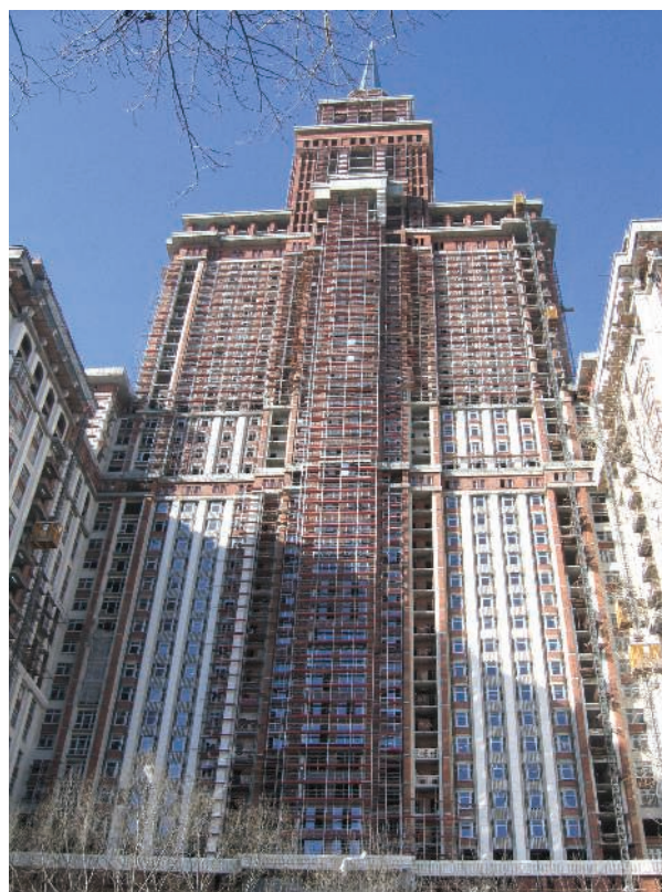
Lešení RINGER s dvojitým zábradlím v Moskvě. Výška 120 m.
