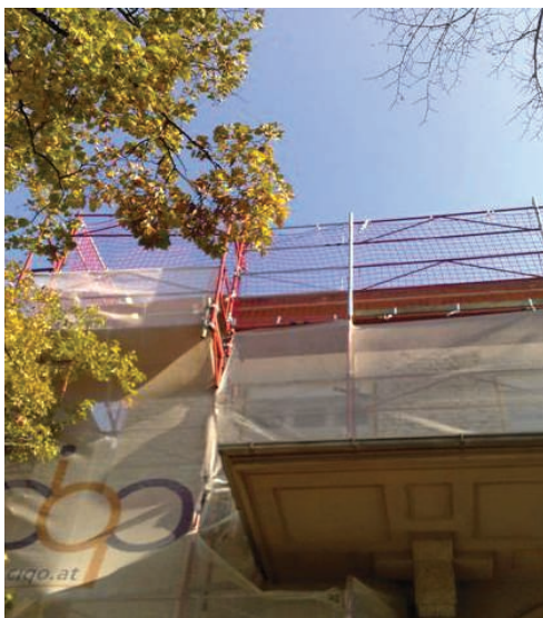
Záchytná konstrukce s vyloženou konzolou
