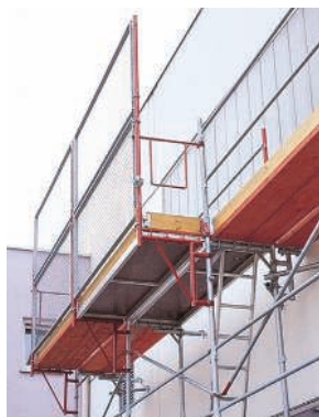
Záchytná konstrukce s vyloženou konzolou
