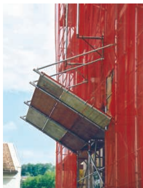
Záchytná stříška s podlahami RINGER. Splňuje normu EN 12801-2
