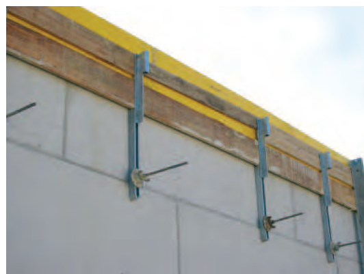
Nastavitelný sloupek na hraně bednění
