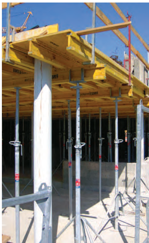
Nastavitelný sloupek na hraně bednění
