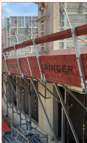
3S platforma za betoniranje za sistem Master
