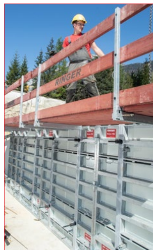
L-platforma za betoniranje Širina 2,70 m
