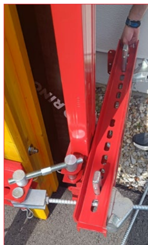
Sistem za zatvaranje bočne oplate
