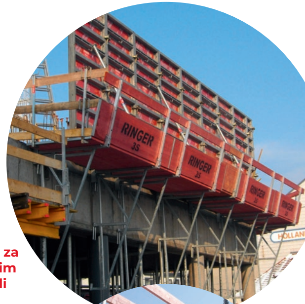
L-platforma za betoniranje
