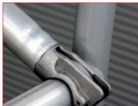
Tesna povezava med spojko in cevjo
