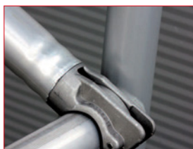
Tesna povezava med spojko in cevjo
