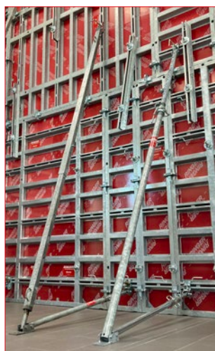
Reg. opora 1 / 2 / G pocinkano, s podaljšanjem do 10 m višine opaža
