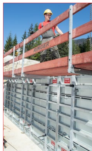
L oder za betoniranje širina 2,70 m
