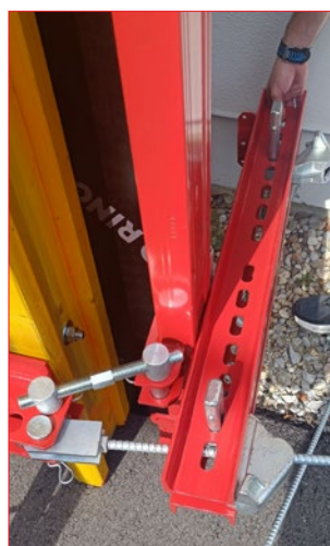
Sistem za zapiranje faze opaža
