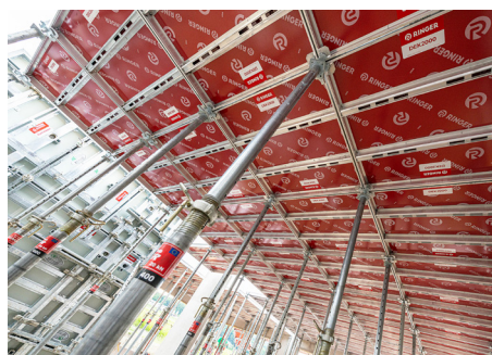
Standard 20kN Stützen ausreichend
