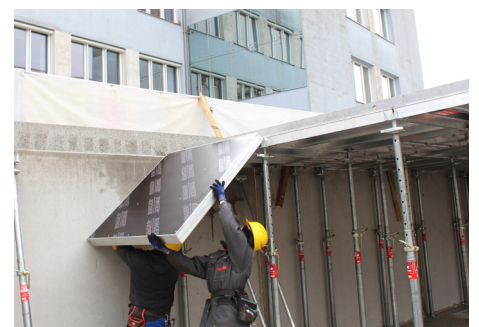
Sicherer Aufbau vom Boden
