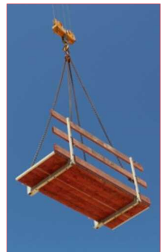
Betonierbühne „L“ Breite 2,70m
