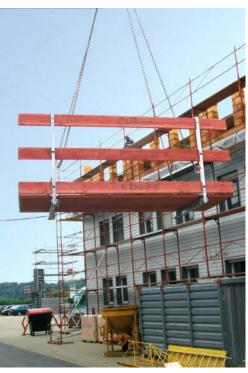
Leichte Betonierbühne für System Master (Alu oder Stahl) und System 2000 (Alu oder Stahl)
