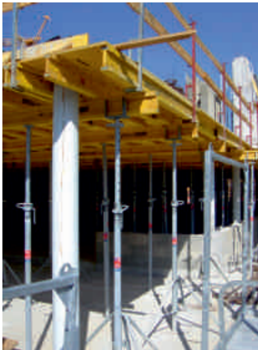
RINGER Deckenrandabschalung mit aufsteckbarem Geländer
