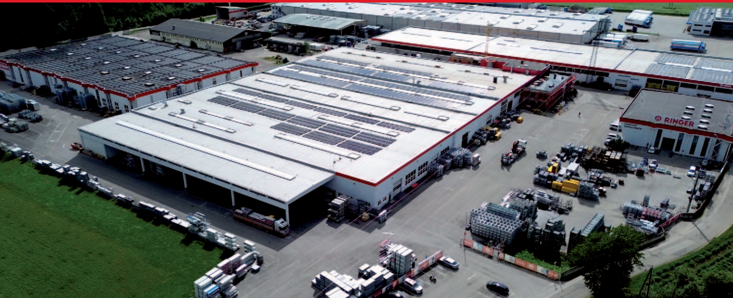
ZENTRALE STANDORT REGAU
