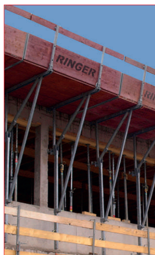
3S Betonierbühne für System Master
