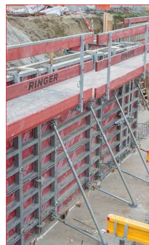
Betonierbühne „L“ Breite 2,70m
